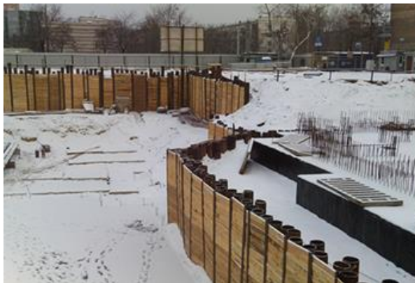
Рисунок 1.3. - Ограждение котлована из стальных элементов с забиркой
